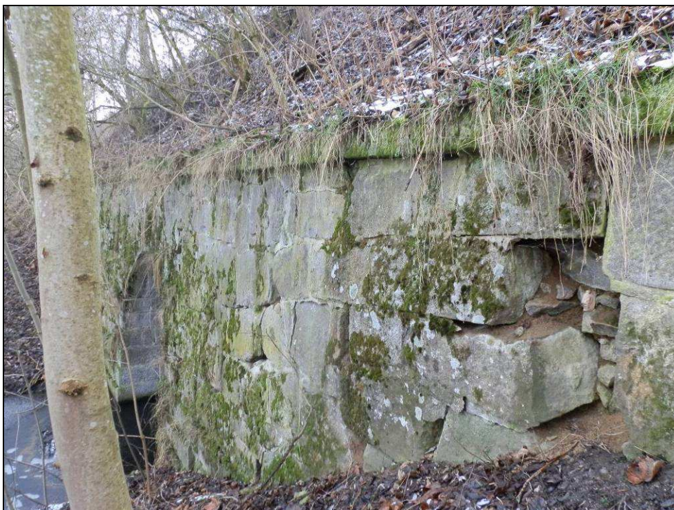
Obr. č. 14 - porucha zdiva pravého čela, zdivo je strukturálně porušené, kameny vypadávají
