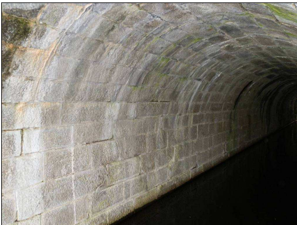
Obr. č. 9 - opěra Nepomuk, zdivo je bez poruch, lokálně zatéká (tvorba vápenných usazenin)
