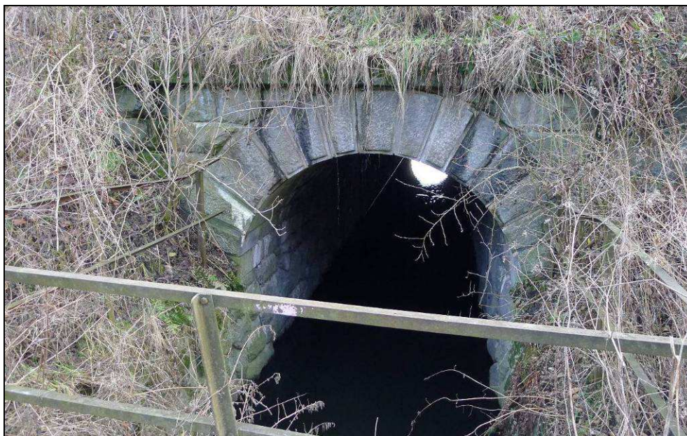
Obr. č. 8 - levé čelo objektu, zdivo je zachovalé, spáry vyspravené, zdivo vlhké
