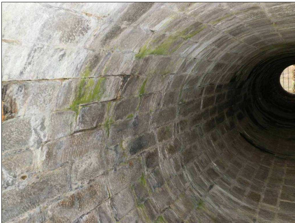
Obr. č. 11 - nosná konstrukce klenba z pravé strany, zdivo je bez poruch, správy jsou místy vypadané a do zdiva zatéká
