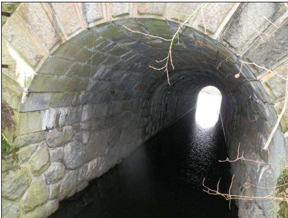
Obr. č. 13 - opěra Nepomuk z leva, původní část (řádkové zdivo) byla rozšířena (řádkové zdivo a zdivo z lomového kamene blíže čelu). Zdivo je bez poruch.
